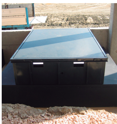
Foso para RH22/RH32 con encofrado (opcional)
